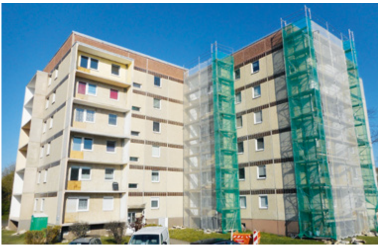
Arbeiten am Gebäude in der Hundisburger Straße
