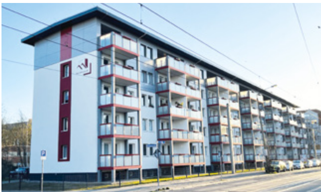
Fertige Fassade an der Großen Diesdorfer Straße
